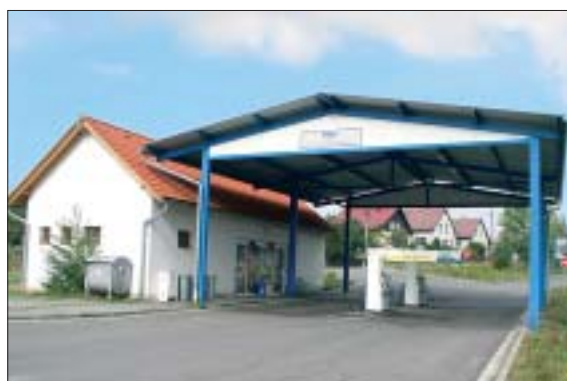
Čerpací stanice – Štoky
